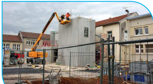
Travaux au Collège
